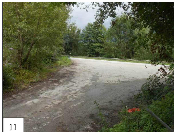
Figure 5 : Prises de vues lors de la visite de site
